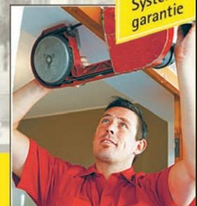
Mit einer Spezialsäge wird der alte Fenster- oder Türrahmen ohne Brech- und Putzarbeiten ausgesägt.
